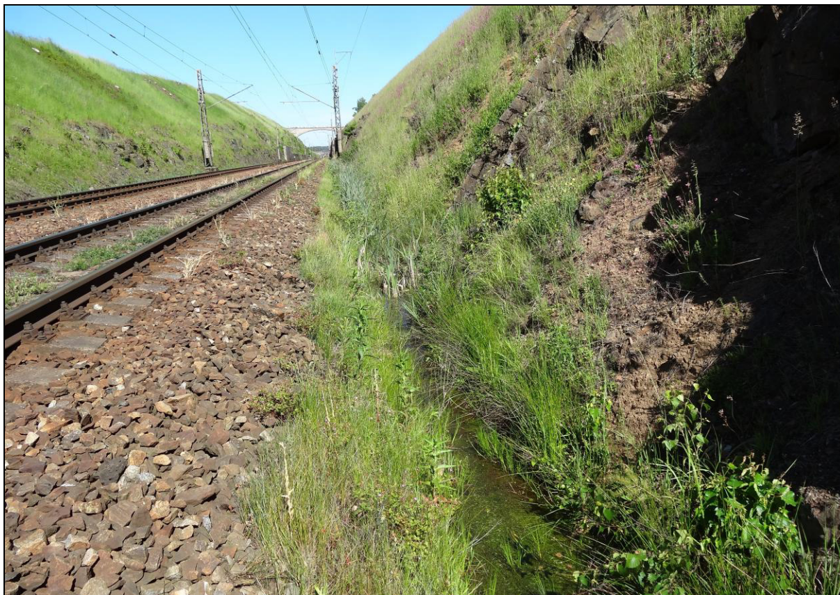
Obr. 5: Zvodnělé příkopy v železničním zářezu mezi ŽST Sklené nad Oslavou a km cca 66,9 (7. 6. 2016)
